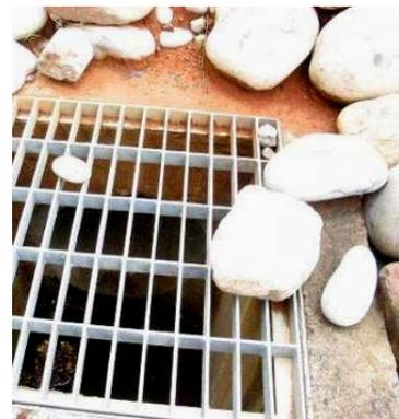
96年6月03日道路工程現勘，生態排水工程之梯型土溝集水井完工現況。
