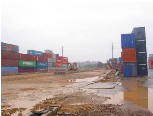
96年3月25日工地現勘現況，道路工程整地階段，既有地上物拆除之廢棄物料應有效回填車道或人行道之路基底層。
