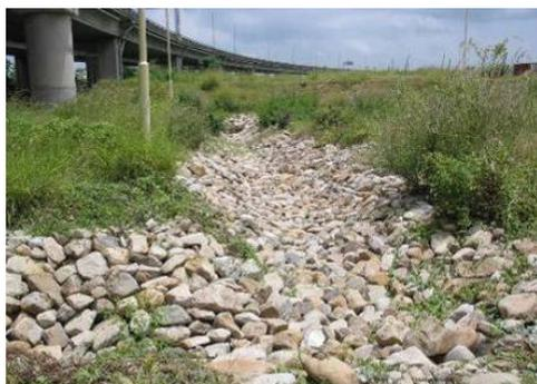
96年6月03日道路工程現勘，道路路側生態排水工程之梯型土溝完工現況。
