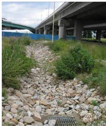
96年6月03日道路工程現勘，生態排水工程之梯型土溝完工現況。
