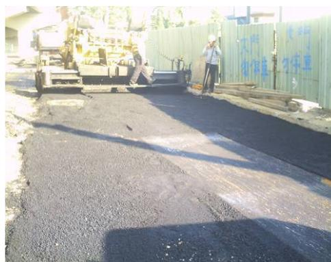
熱拌再生瀝青混凝土鋪設現況
