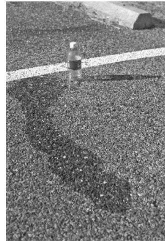
▲圖 3-17 使用玻璃瀝青混合材料
