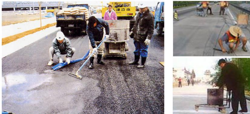
▲圖 3- 39 道路填縫料施工
