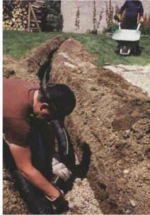
▲圖 3- 41 PVC 排水管的替代產品裝設
