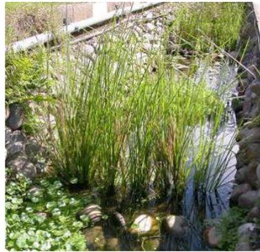
排水溝渠透過斷面計算及評估後也可以扮演生態廊道的角色
