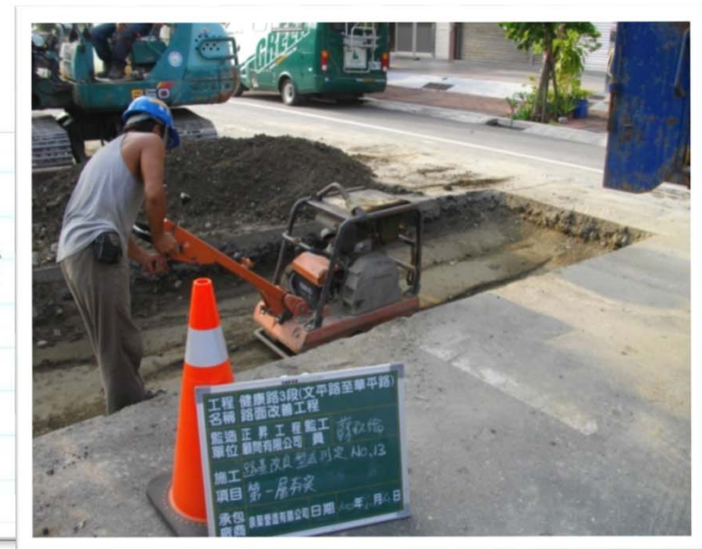
路基改善分層夯實
