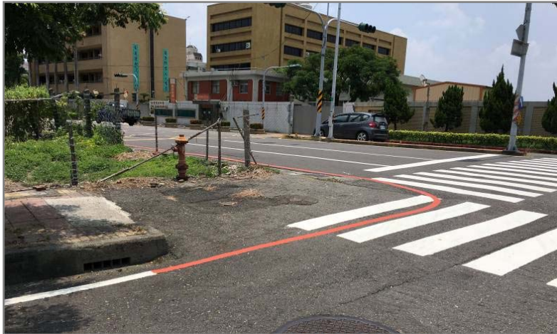
▲斜坡道不平整且早期建置缺乏無障礙設計觀念
