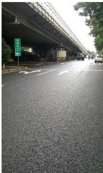
多孔隙瀝青混凝土
