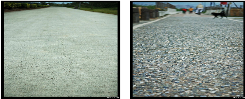
圖 4-3 混凝土鋪面實例
