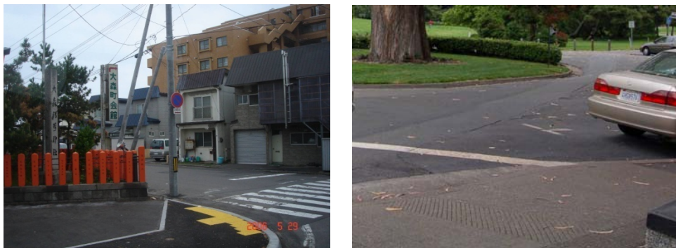
圖 3-31 引導磚及定向斜線之使用
