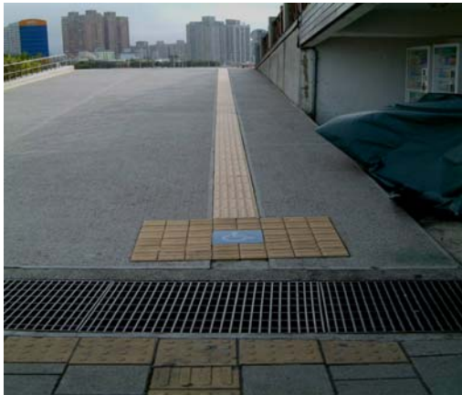
圖 3-24 蓋板與行進方向平行(左圖)，孔蓋設計不良(右圖)
