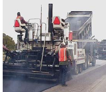
澆置瀝青混凝土
