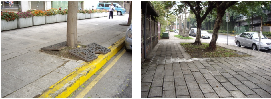
圖 3-21 行道樹樹根隆起、盤根錯節之現象
