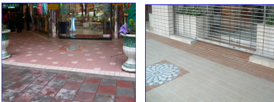
圖 3-33 與建築物及道路銜接處設置斜坡
