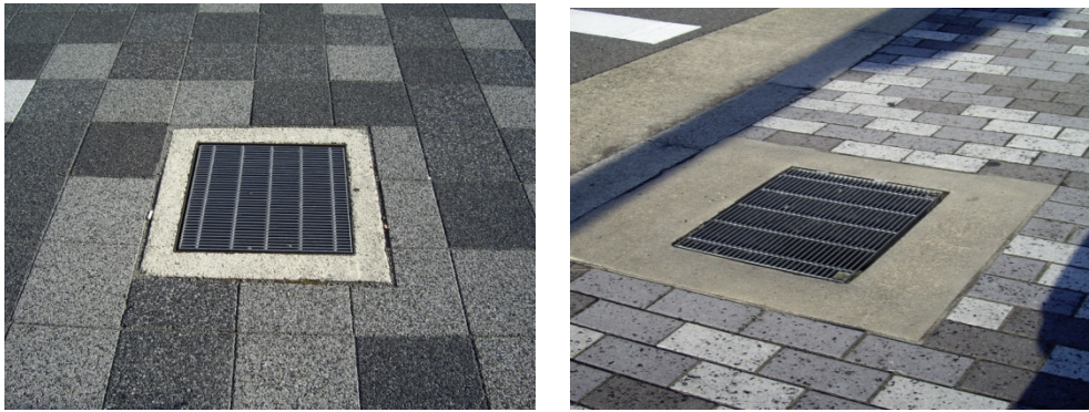
圖 3-35 孔蓋縫隙不宜太寬且須與行進垂直
