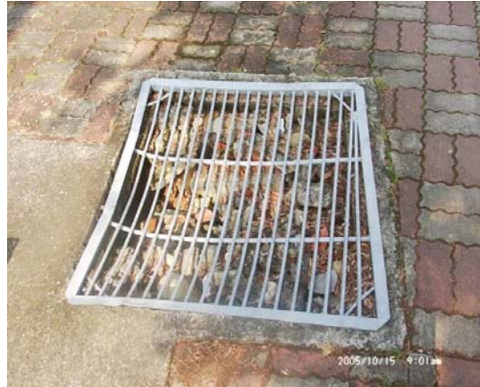
圖 3-24 蓋板與行進方向平行(左圖)，孔蓋設計不良(右圖)
