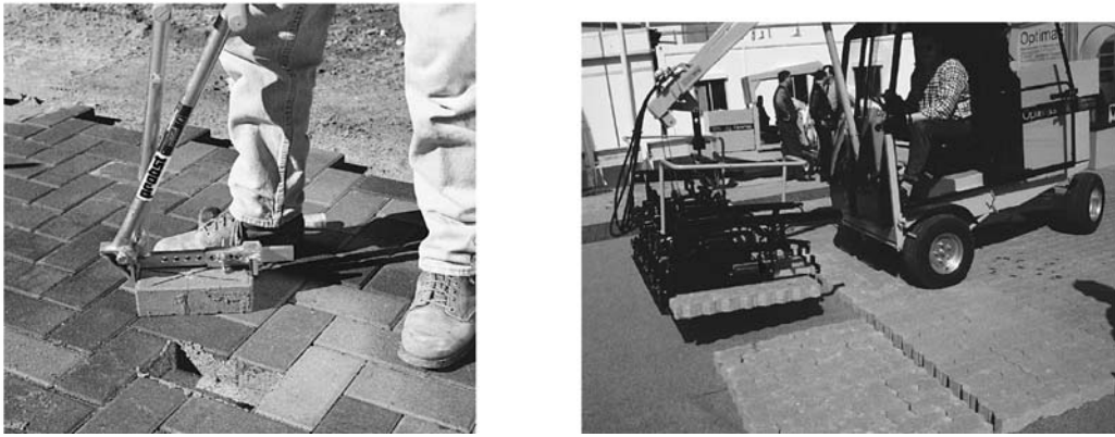
圖 4-31 透水磚移除工具及大範圍之透水磚、連鎖磚鋪面移除
