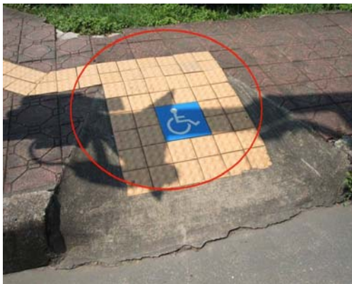
圖 3-25 導盲磚鋪設錯誤(左圖)，無導盲磚鋪設(右圖)
