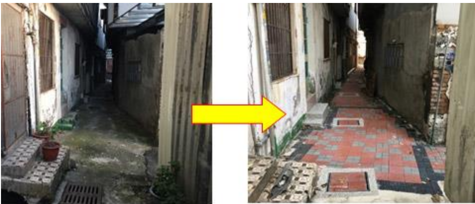
圖 16 高壓透水磚鋪面改善示意圖
