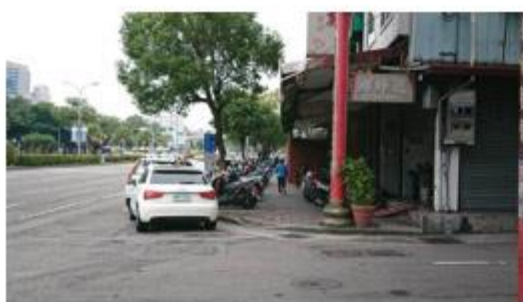
人行道未設置無障礙斜坡道
