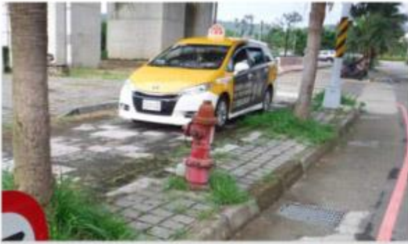
大坡面斜坡道易使車輛闖入人行道
