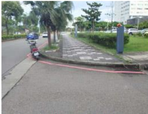
(E)未設置無障礙斜坡道
