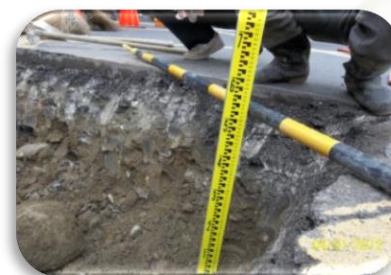
■ 路基改善施工
